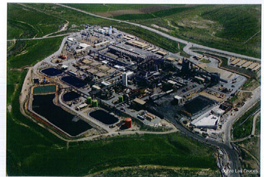
Figura 5. Vista general de las instalaciones de la Planta hidrometalúrgica de Cobre Las Cruces, S.A.
