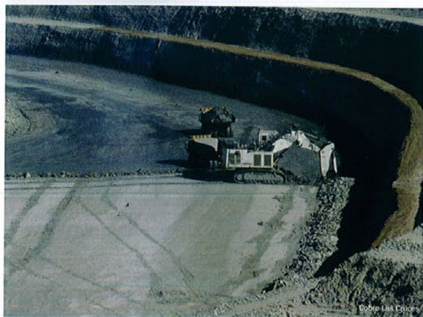
Figura 2. Retroexcavadora LB 9350 de 20 m 3 operando en el desmonte de la fase 3. En las cotas superiores, las margas se arrancan directamente en tres cortes, hasta dejar bancos de 10 m. Obsérvese la berma impermeabilizada para retardar la acción erosiva causada por la infiltración de agua de lluvia.
