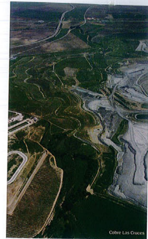
Figura 8. Los desvíos de los arroyos (en la imagen el Molinos) se diseñan siguiendo trazados naturalizados y son restaurados inmediatamente después de su ejecución.
