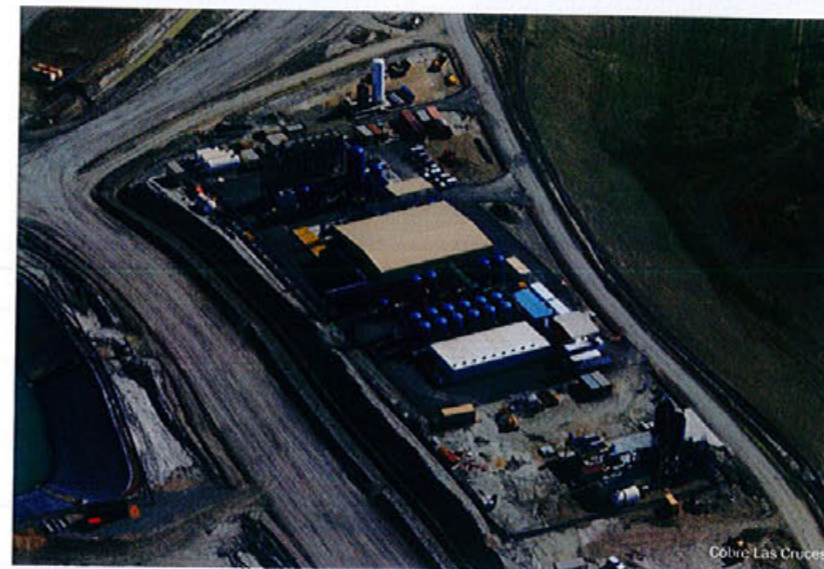
Figura 7. Planta permanente de tratamiento de aguas y planta de acondicionamiento de aguas de contacto.
