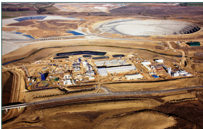
Vista aérea de la Planta de Tratamiento de CLC a finales de junio pasado.
