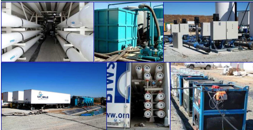
Imágenes de la planta de tratamiento temporal de agua lista a finales de verano que realiza un proceso de ósmosis aumentando la calidad de las aguas del acuífero Niebla-Posadas, siempre que sea necesario.
