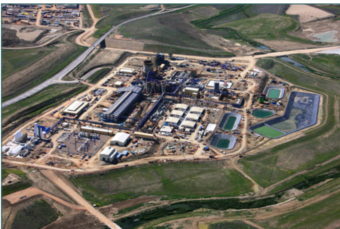
IMAGEN 1. VISTA AÉREA DE LA PLANTA DE TRATAMIENTO MINERAL, MARZO 2008.
