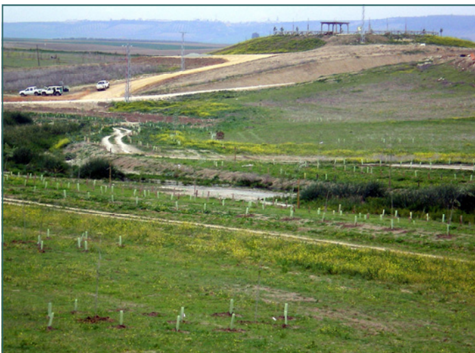
IMAGEN 1. RESTAURACIÓN DEL ARROYO GARNACHA, FINALIZADA EN 2008.
