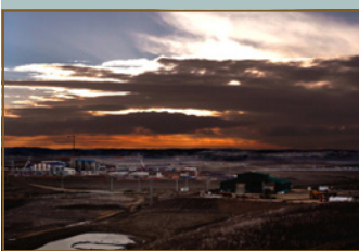
Atardecer en la zona de construcción de CLC.
